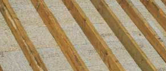
Первый этап – демонтаж кровли, утеплителя и старых плёнок.
