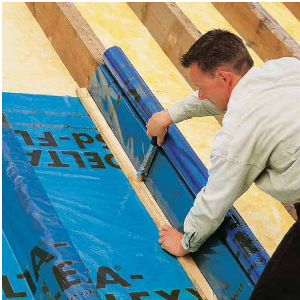
Плёнка DELTA®-Sd-FLEX монтируется очень быстро, снижая общее время проведения ремонта.
