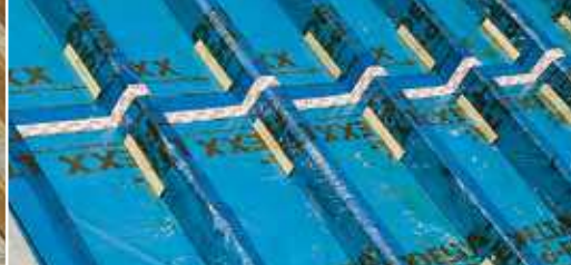
После монтируется DELTA®-Sd-FLEX.
