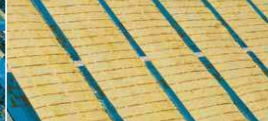
Укладка нового утеплителя.
