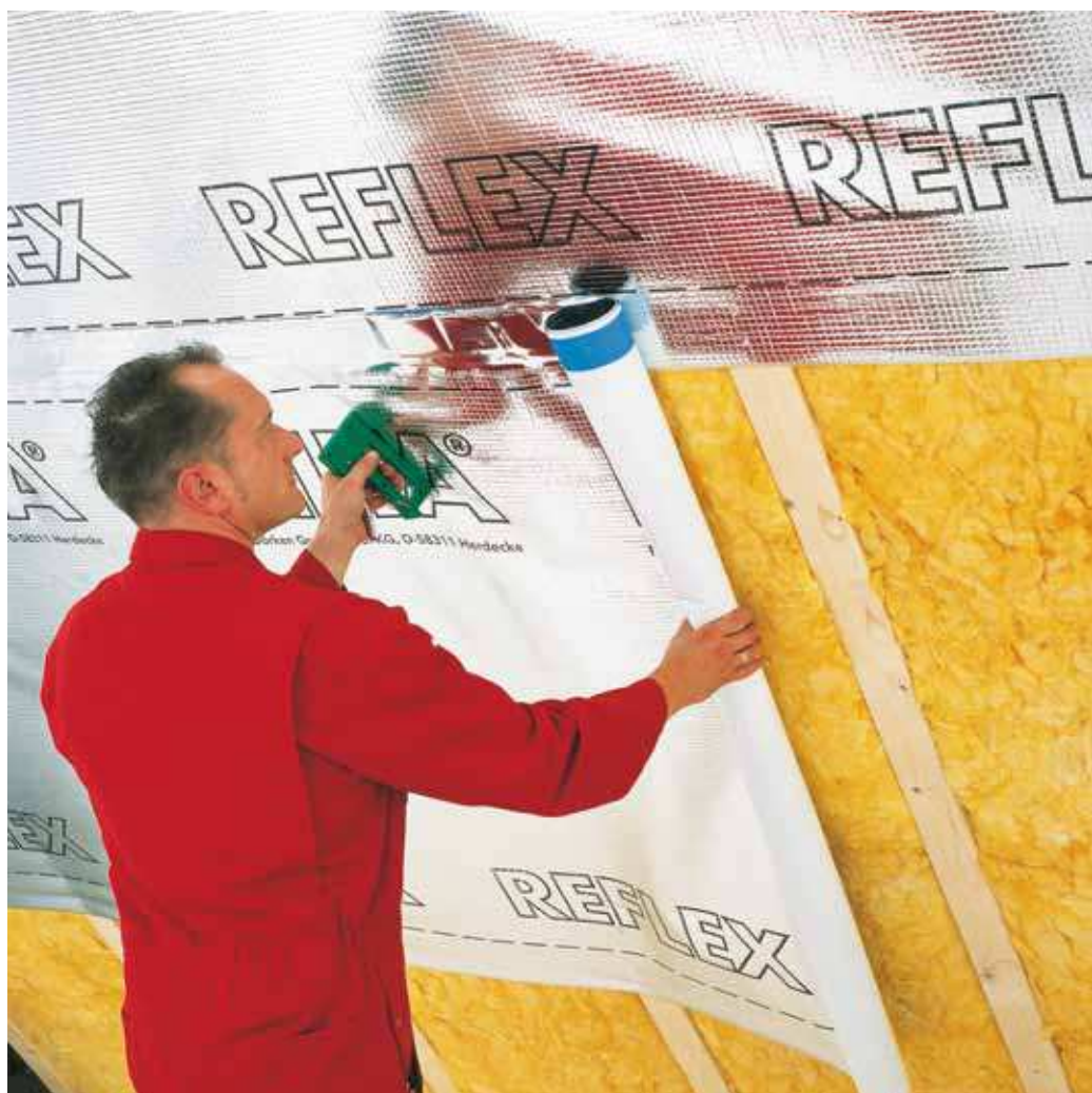
Плёнки DELTA®-REFLEX/REFLEX PLUS являются универсальными пароизоляционными материалами.
