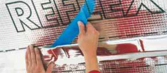
Воздухонепроницаемость благодаря интегрированной ленте.
