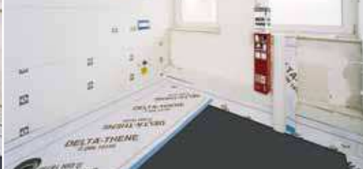
Гидроизоляция пола во влажных помещениях.
