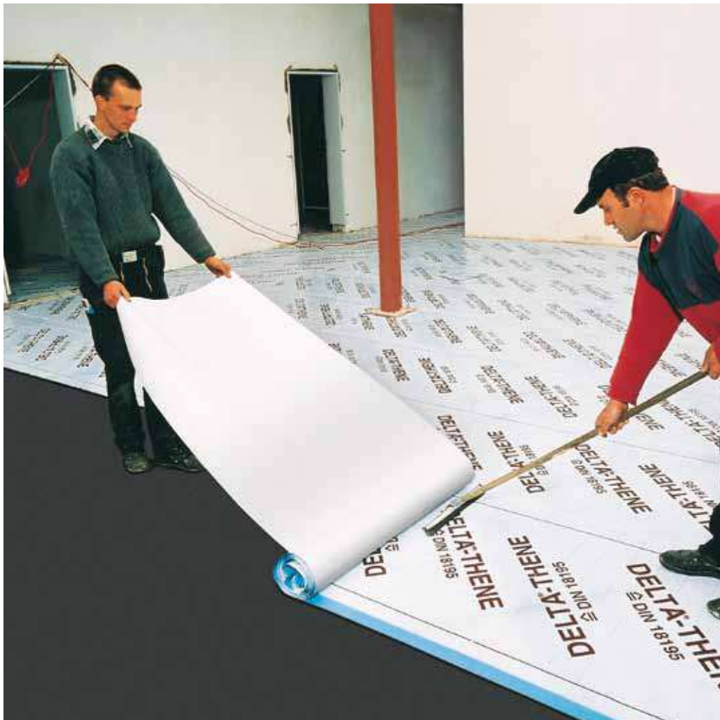
С помощью DELTA®-THENE очень просто обеспечить гидроизоляцию больших площадей.
