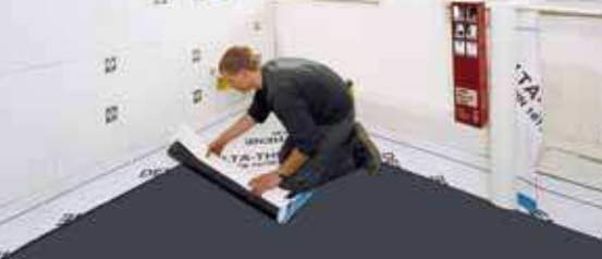
Быстрая укладка без наплавления.
