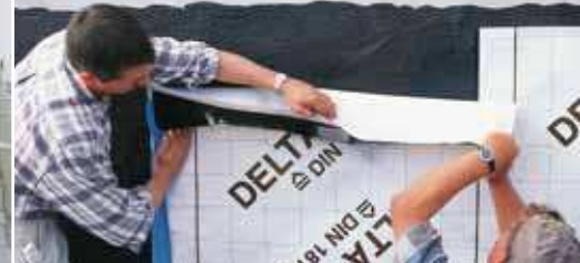
Гидроизоляция стен подвалов.
