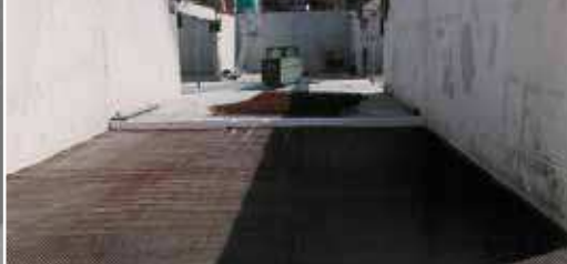
Замена бетонной подготовки под фундаментной плитой.
